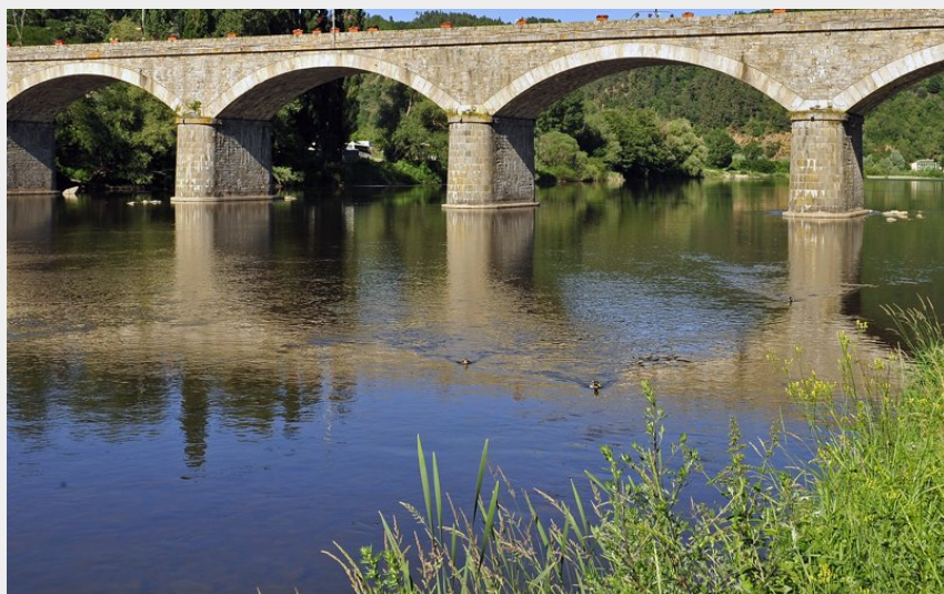
Pont de l'Europe sur la Loire (Ch. Bertholet)
