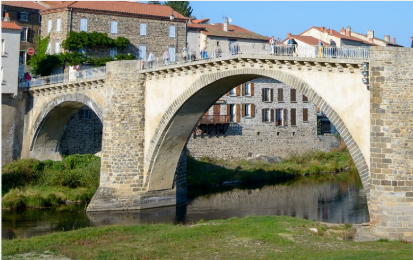
Pont de Lavoûte-Chilhac (J. Mazet)
